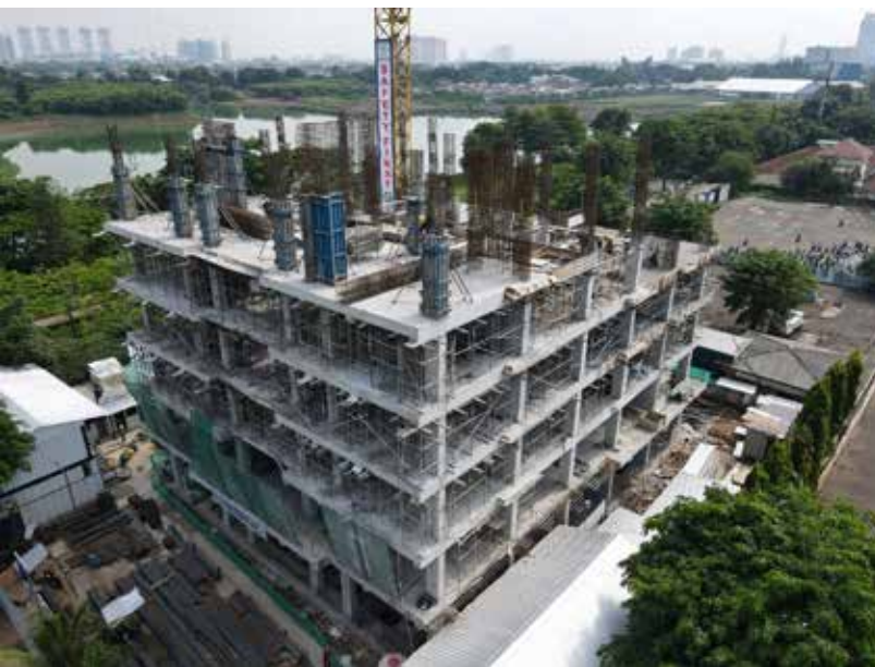
Gambar Pembangunan Rusun MA
